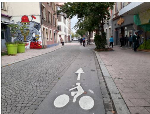
Bande goudronnée dans une rue pavée à Strasbourg
