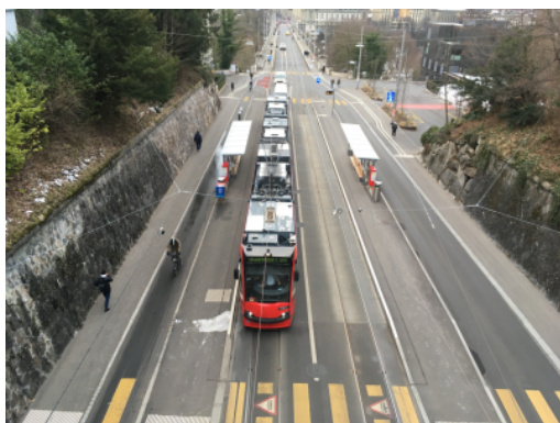
Bypass vélo à l'arrêt de tram/bus Kursaal à Berne
