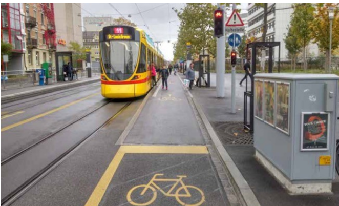
Veloinsel mit Lichtsignalanlage in der Hünigerstrasse, Basel. Quelle: Velokonferenz Schweiz, 2019
