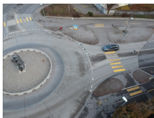
Giratoire "Schachenkreisel" avec pistes cyclables séparées à Lyss
