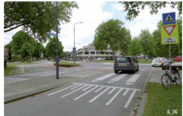
Décrochement vertical permettant d'abaisser la vitesse des automobilistes au carrefour aux Pays-Bas. Source: OFROU & Conférence vélo, 2021
