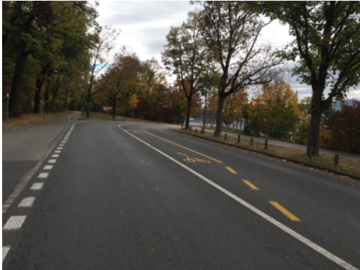
Bande centrale pour tourne-à-gauche directe à la Murtenstrasse à Berne
