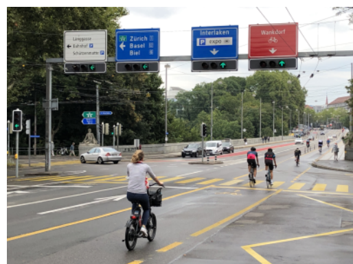
Feux pour cyclistes près du Lorrainebrücke, Berne
