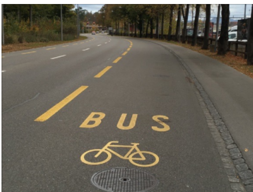
Veloführung auf der Busspur entlang der Murtenstrasse, Bern
