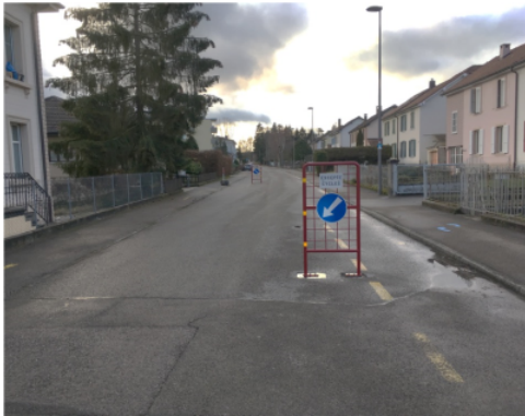
Tempo-30-Zone in Porrentruy mit einem Hindernis, das den Weg für Velofahrer:innen nicht unterbricht
