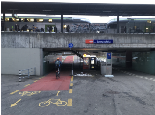
Aménagement spécifique permettant de limiter les conflits entre les piétons (en particulier les usagers du train descendant du quai) et les cyclistes à la station RER Europaplatz à Berne
