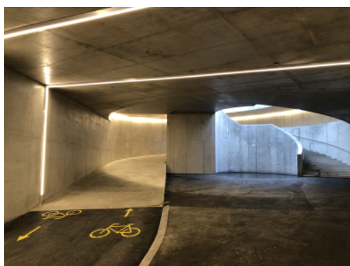
Passage inférieur à la gare de Prilly-Malley
