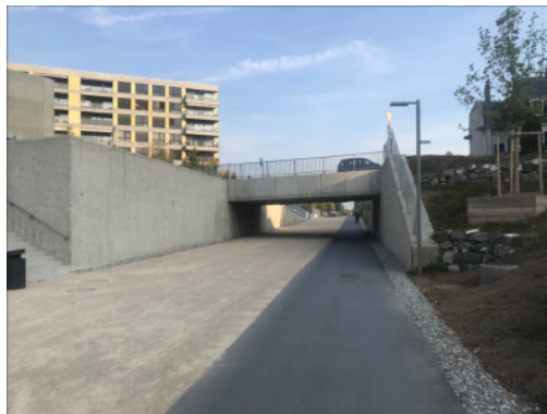
Passage inférieur sur la voie verte à Genève
