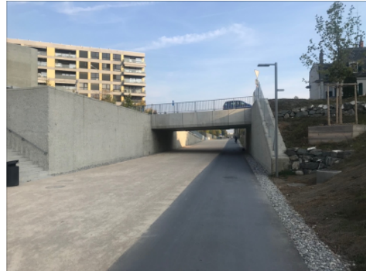
Unterführung auf der «voie verte» in Genf
