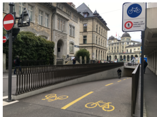
Velotunnel am Bahnhof Winterthur
