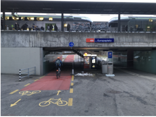
Abgetrennte Velofahrbahn in der Unterführung an der S-Bahn-Station Europaplatz in Bern. Durch die getrennte Führung werden Konflikte zwischen Fussgänger:innen (insbesondere Pendler:innen, die vom Perron herunterkommen) und Velofahrenden vermieden
