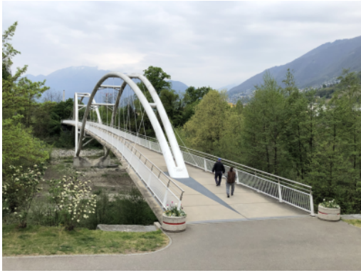
Passerelle à Monte Carasso
