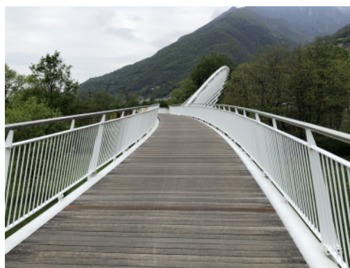
Passerelle à Locarno
