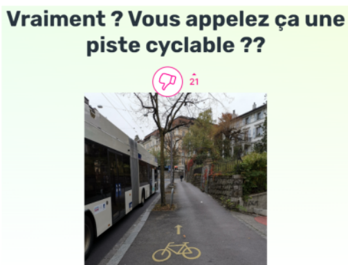
Beispiel für einen identifizierten Problempunkt, Lausanne. Quelle: Bikeable
