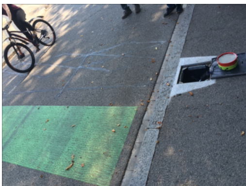
Zählstelle mit unterirdischer Induktionsschleife an der Dreibeinskreuzstrasse, Solothurn
