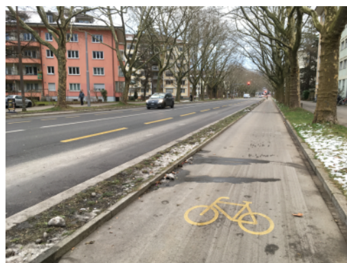
Piste cyclable unidirectionnelle avec séparation du trafic le long de la Winkelriedstrasse, Berne
