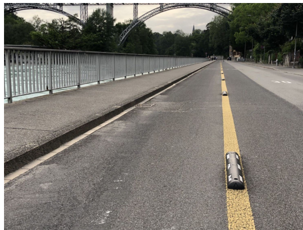
Radwegtrennelemente zur zusätzlichen Sicherung des Radstreifens in der Matte, Bern
